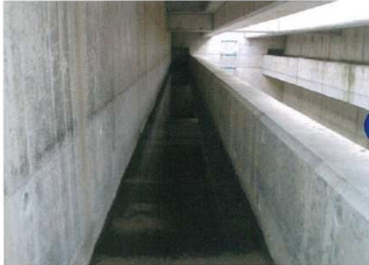
矩形池施工前(トラフ内)
