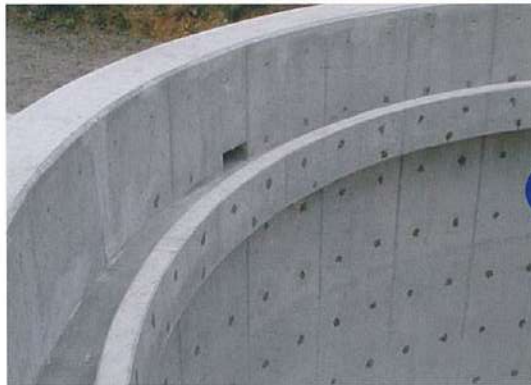
円形池施工前
