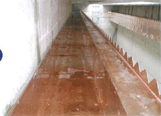
矩形池施工後(トラフ内)
