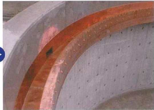
円形池銅板施工後
